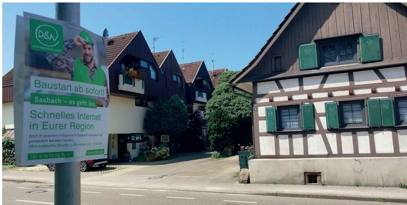
Der Glasfaserausbau in Sasbach geht weiter. • Foto: DBN • hochgeladen von Matthias Kerber
