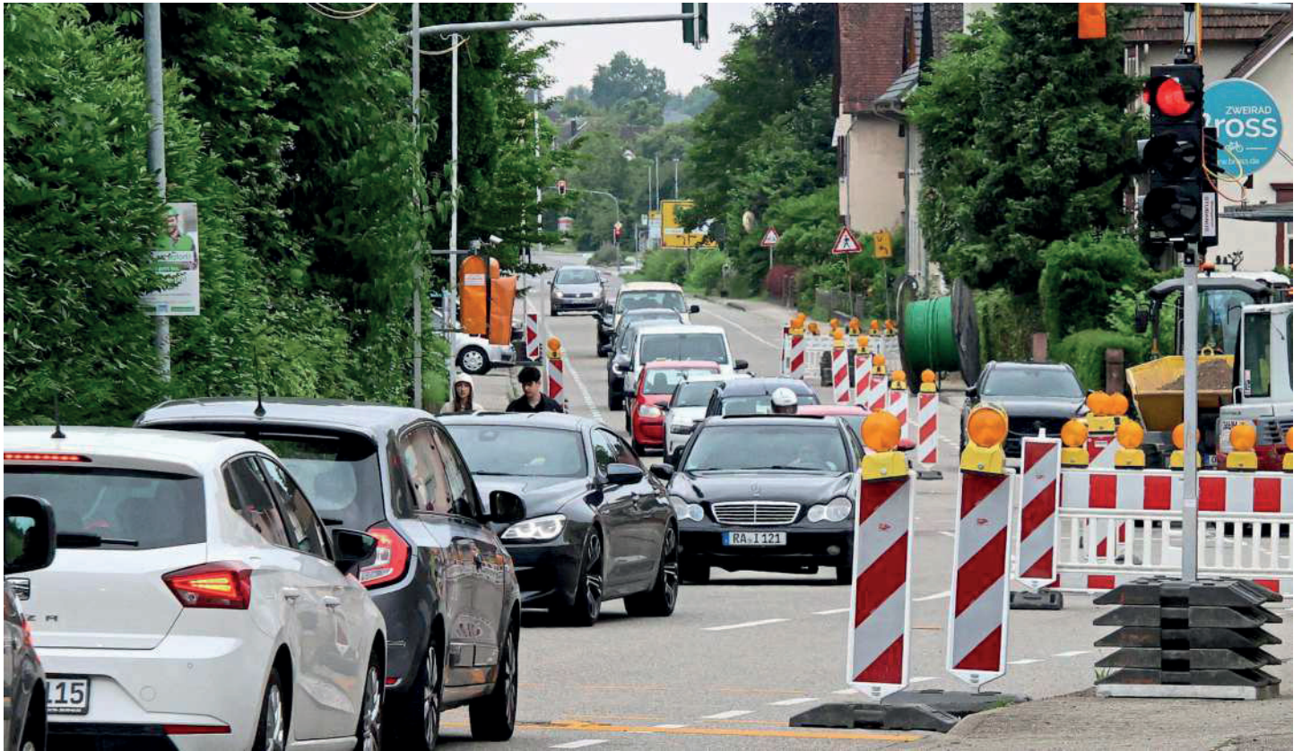
Für das schnelle Internet müssen entlang der Hauptstraße Glasfaserkabel verlegt werden, deshalb gibt es bis Anfang Juli noch eine Teilsperrung mit Ampelregelung – hier bei der Einmündung in die Gartenstraße, in der auch Kabel verlegt werden. Foto: Roland Spether
